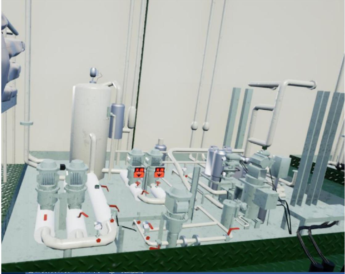
image 8-35 分油机间主机燃油控制单元
