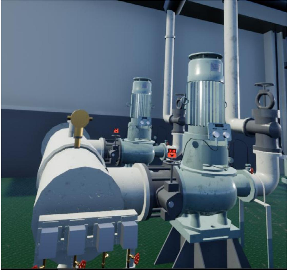
image 8-39 热水井至给水泵泵前阀
